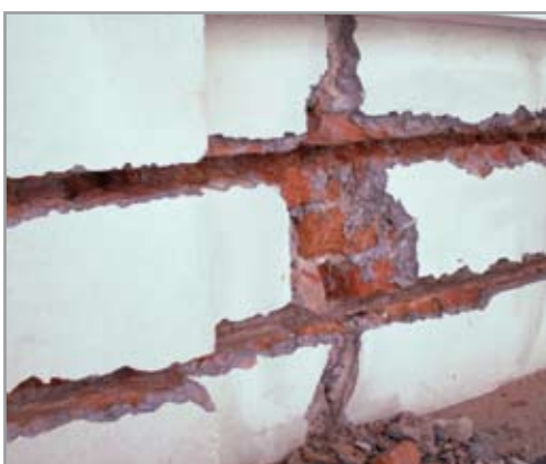
Ряд прорезей в кладке
