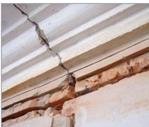
Ряд прорезей в кладке
