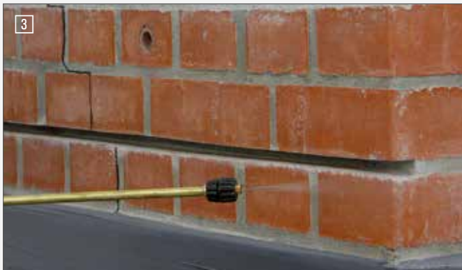
3 Предварительно увлажнить шов Wet the joint / slot
