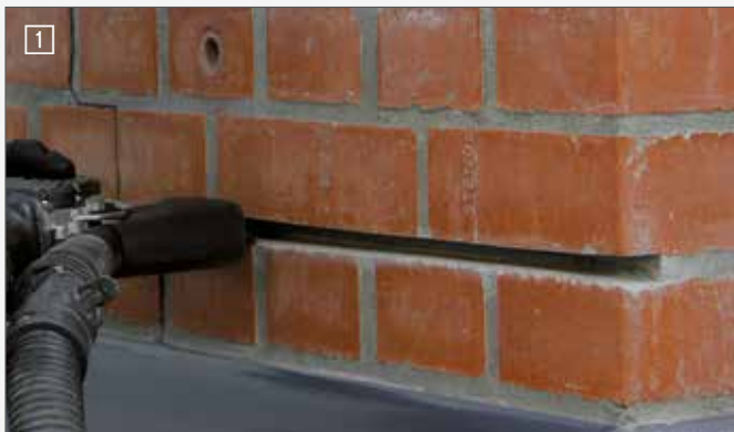
1 Выпилить шов камнерезной пилой AS170 или награткой Cut the joint / slot by using the AS0170 Brick and mortar saw
