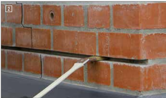
2 Зачистить шов Clean the joint / slot
