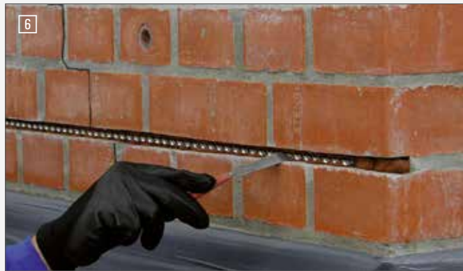
6 Вдавить спиральный анкер в раствор Embed the spiral anchor
