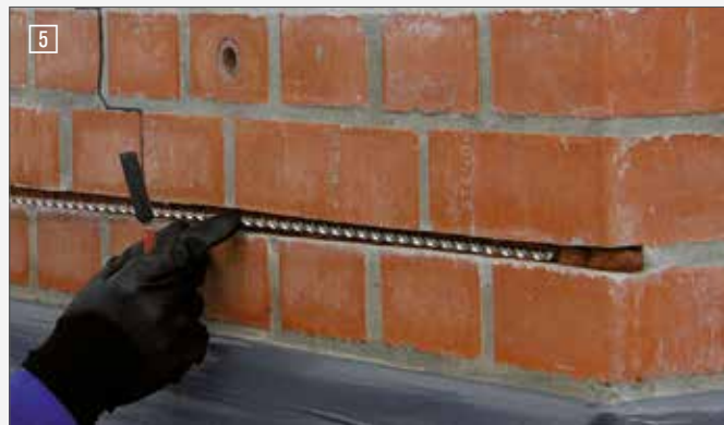
5 Установить спиральный анкер Place the spiral anchor
