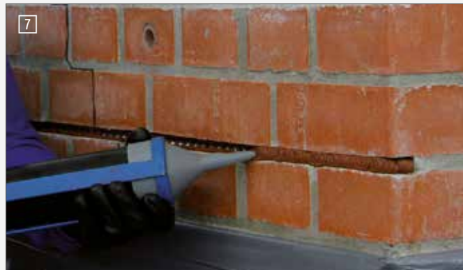
7 Ввести второй слой раствора Inject the Spiral anchor mortar
