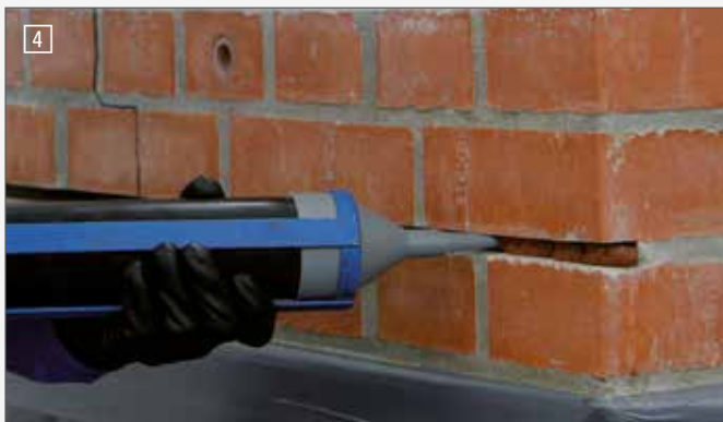
4 Ввести первый слой раствора Inject the Spiral anchor mortar
