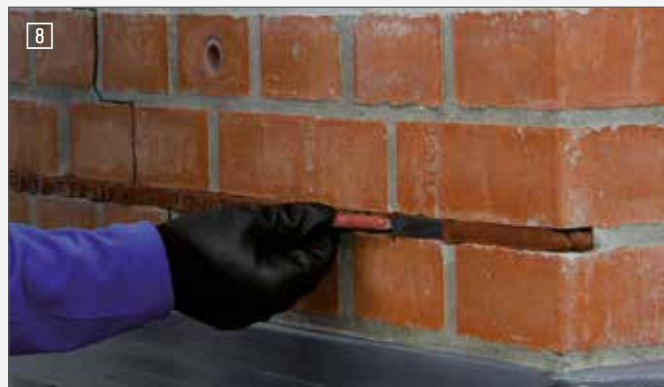
8 Раствор разгладить Flatten out the mortar
