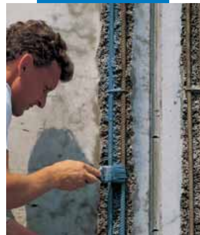
Нанесение смеси Mapefer
