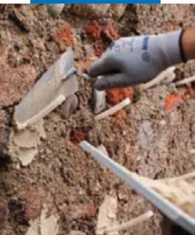
Фиксация резиновых трубок с помощью Mape-Antique Allettamento
